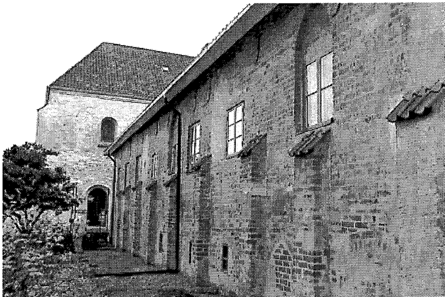
Fig. 6. Dalby kungsgård, boningshusets östra fasad efter nedknackning av puts (foto: G. Eriksdotter | 1994).
