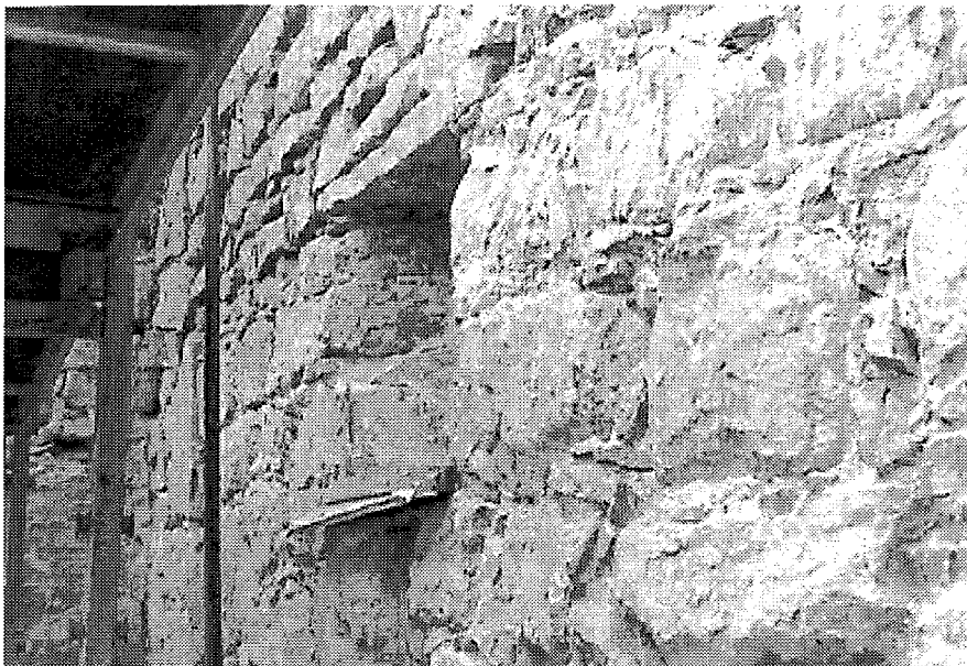
Fig 3. Restaureringen av Ytterenhörna kyrka 1994. Den hårda putsen bilades bort och gav skador i murverket. Foto Gunilla Gardelin.
