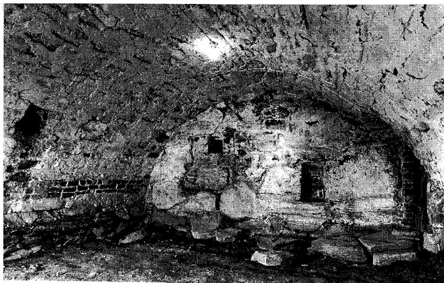
Figur 3. Källaren på Laukko är ett av de största välvda utrymmena i Finland med dimensioner på c. 6x8 meter och en höjd på nästan 4 meter. Källaren är murad i framför allt gråsten och bara ställvis i tegel.
