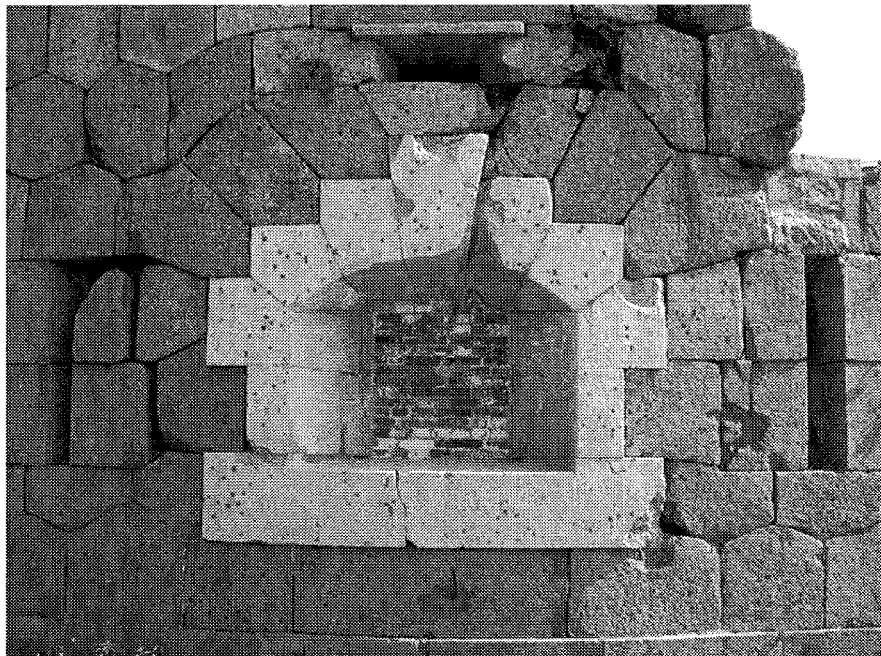
Figur 5. Fasad av Brännklint som visar märken efter krypskyttarnas kular, kanonkolor och mörsarbomber.
