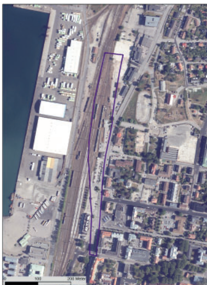
Figur 1. Karta med undersökningsområdet i Varberg. Varbergs nuvarande station ligger till vänster i bild längst i söder bredvid undersökningsområdet. Skala 1:3000. Foto: förf.
