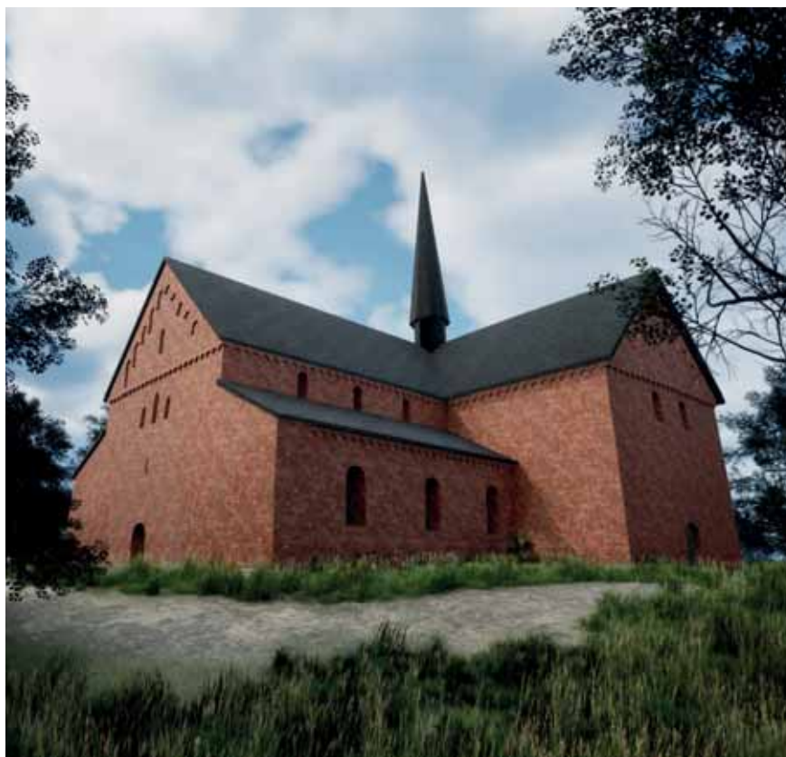
Figur 9. 3D-rekonstruktion som visar en variant av kyrkan med takryttare över korsmitten. Illustratör: Joel Eriksson Stomberg, Lödöse museum, 2022.
