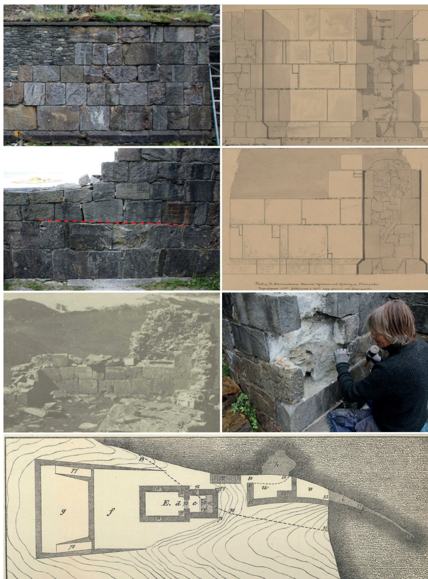
Øverst fra venstre: Figur 3AB Kristkirkens kvaderstein (RM 2020) samt oppmålingstegning av Albanuskirkens murverk, det vil si partiet av den opprinnelige Kristkirken (Johan Meyer 1892, Riksantikvarens arkiv). Figur 3CD Sunnivakirkens kvaderstein i indre vestmur (RM 2020) samt oppmålingstegning av samme mur (Johan Meyer 1892, Riksantikvarens arkiv). Figur 3E Samme mur fotografert i 1909 like før Rivertz' restaurering (Riksantikvarens arkiv). Figur 3F Murmester Geir Magnussen meisler ut tilført gneis i sement fra restaureringene for å finne original murkjerne (RM 2020). Figur 3G Otto Kreftings plan av terrasseanlegget, Sunnivakirkeruinen samt heller og hule i 1868 (Riksantikvarens arkiv).
