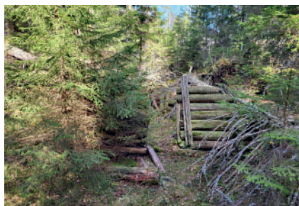
Figur 8. Den förfallna timmerbyggnad som påträffades i närheten av markeringen för kolartorpen (L2024:8400). Foto: Andreas Widerberg, Länsmuseet Gävleborg.
