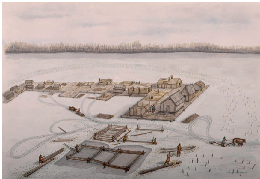
Figur 2. Konstnärligt förslag över hur det kan ha sett ut när Bulverket uppfördes i början på 1130-talet. Att döma av hur okkistorna är sammankopplade med varandra konstruktionsmässigt, bör byggnadsverkets fundament ha byggts på vinter från isen. Illustrationen figurerar endast byggnadsteknikerna skiftesverk och knuttimring, där tillräckligt många delar idag finns dokumenterade för trovärdiga rekonstruktionsförslag. Byggnadsteknikerna stavverk och flätverk har inte tagits med. Illustration: författaren 2023.
